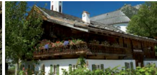
Polzknasparhaus in der Garmischer Fußgängerzone Polzknasparhaus - Garmisch's oldest house
