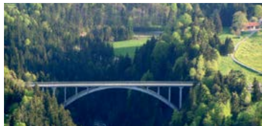
Echelsbacher Brücke Echelsbacher Bridge
